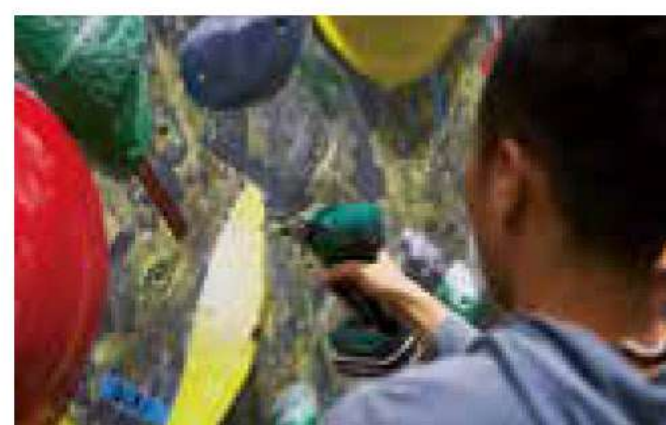
少しでも緩んでいるホールドがあれば、すぐに締めて固定。安全管理も森さんの大事な仕事
